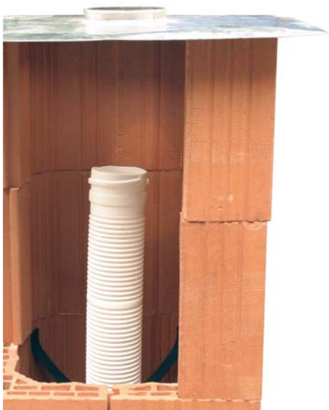
5. Zkrácení ohebného potrubí
